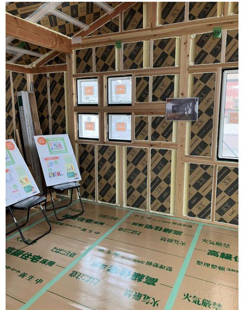
13日には専門家による気密測定会も開催しました。気密測定会では、家を密封状態にして、家の中に存在する隙間面積（C値）を計測します。C値を計測することで、この家の気密性能が分かります。気密性能が高いと隙間が少なく、温まった空気や冷えた空気が逃げにくく、断熱の効果を発揮できる家ということになります。
