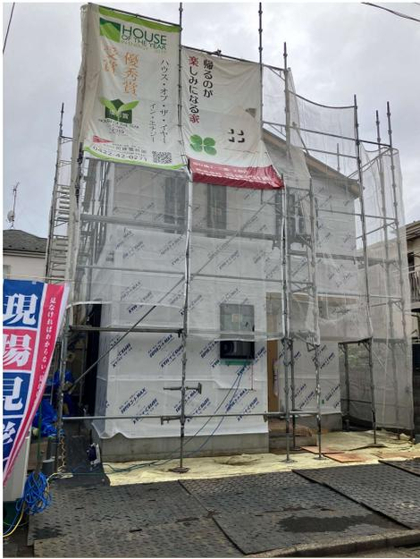
↑外観：断熱材の外側に透湿防水シートを貼っています。断熱材の外で結露した水分を外壁との間の通気で乾かし、断熱材の劣化を防ぐ役割があります。
