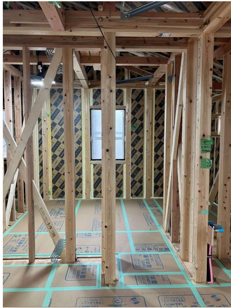
↑内観：図面や完成パースをご覧いただきながら、自由に見学をしていただきます。100mmの厚さのスーパーウォールを柱の間に張り巡らしています。スーパーウォールは硬質ウレタンフォームの断熱材で、工場にて厳しい品質管理のもと生産されています。35年間の無結露保証もされている断熱材です。
