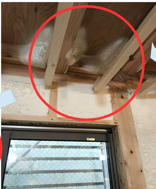
断熱材の吹付は隅々まで。外部と内部をつなぐ金物の部分もしっかりと吹き付け施工します。金物をしっかり断熱することで、内部結露を防ぎます。
