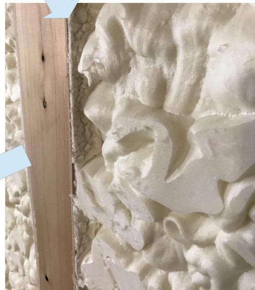
断熱材の発泡ウレタンの吹き付けの拡大写真です。シックハウスの原因となるホルムアルデヒドも含まない、環境に優しい断熱材です。職人さんの手によって丁寧に吹き付けられています。
