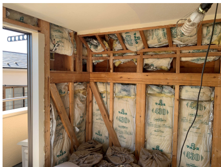
↑解体時： 既存の断熱材の状態
