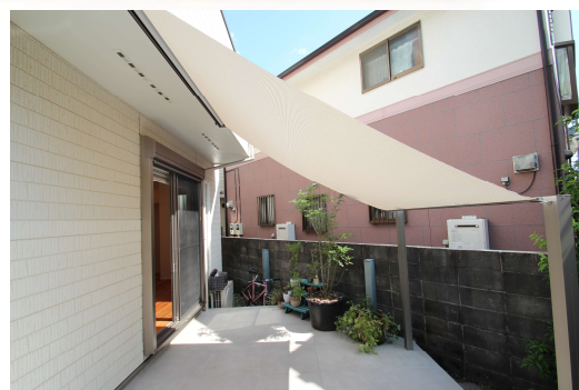
↑ J様邸 スタイルシェードというアイテムを使って、太陽の熱を窓の外側でカットして、室内の温度を心地よくキープする方法もあります。
