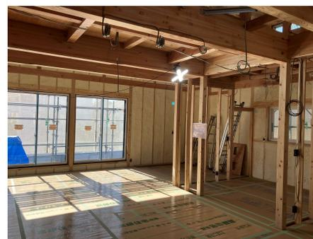
↑壁には100mm、屋根には200mmの厚さで断熱材を吹き付けています。
